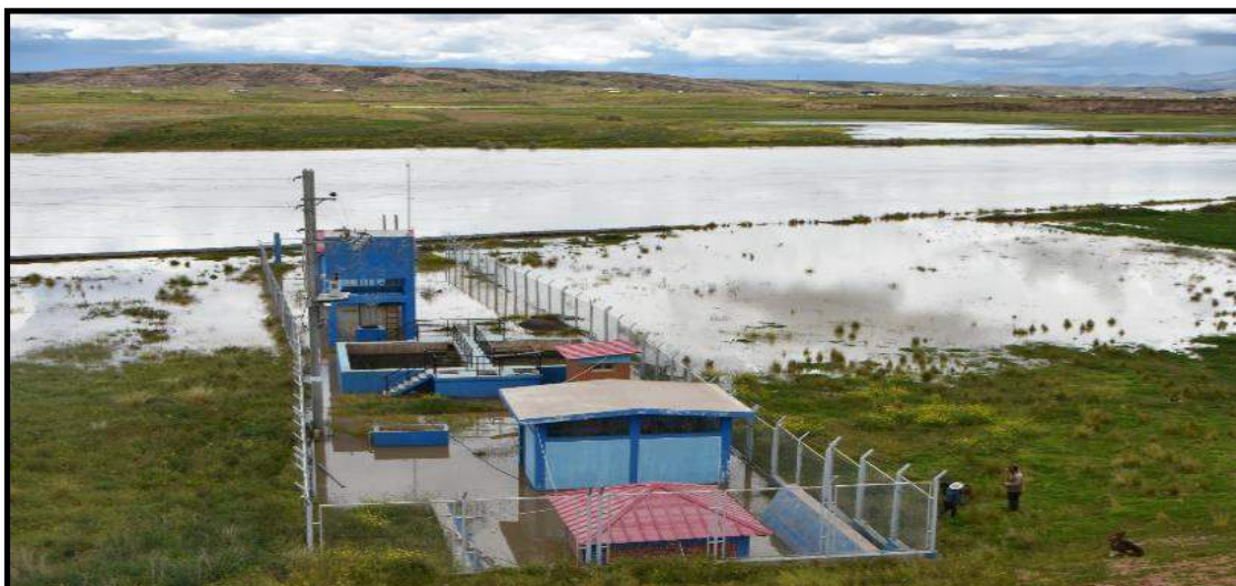
FIGURA N°03: EN LA TEMPORADA DE MAXIMAS AVENIDAS, EL RÍO AZANGARO SE DESBORDA EN ESTE TRAMO DEL SECTOR C.C COLLANA, AFECTANDO LA PLANTA DE TRATAMIENTO DE AGUA POTABLE
